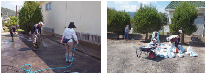
▲災害ボランティア土砂撤去作業の様子▲
